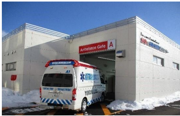
救急&感染症制御後志センター救急車ドック
